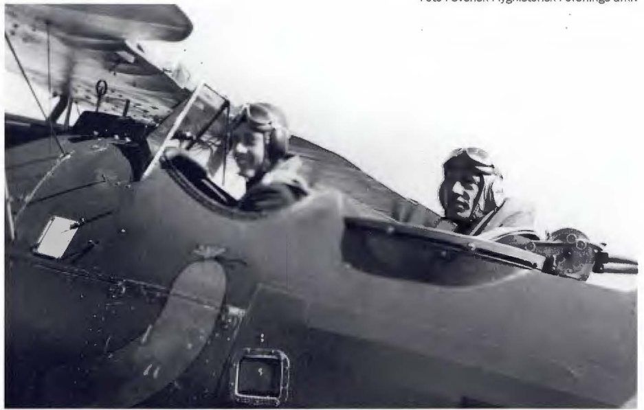
Ovan: Det intressanta med denna bild är väl främst korven som är målad under förarplatsen. B 4 Hawker Hart användes bland annat för bogsering av skjutmål i form tygstrutar, kallade "korvar".
